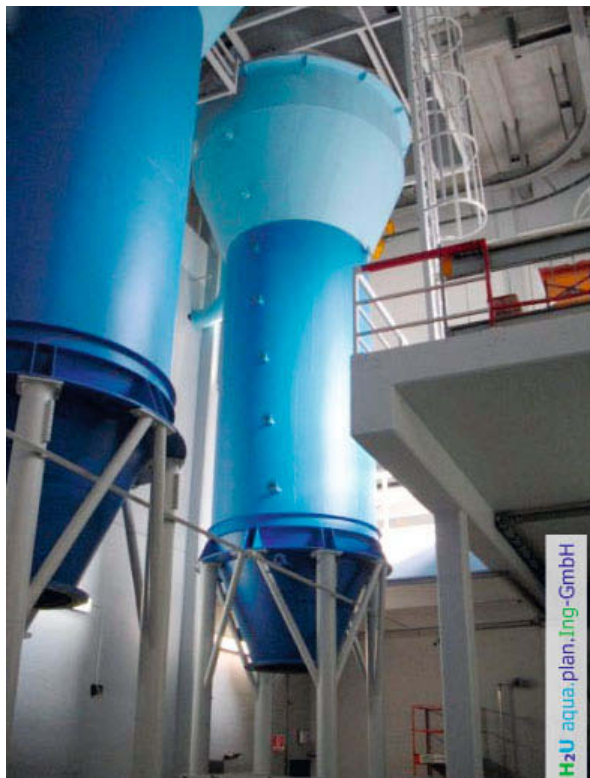
Bild 5. Sanierte Reaktoren im WW Rheinau.
